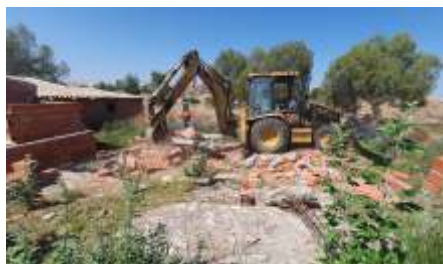
Apreensão de materiais e equipamentos de construção e demolição de construção ilegal em Mourão, no acampamento, junto ao Bairro Luís de Camões, em 05.08.2024.
