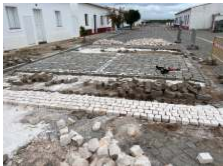
Execução de lombas e passadeiras novembro 2022
